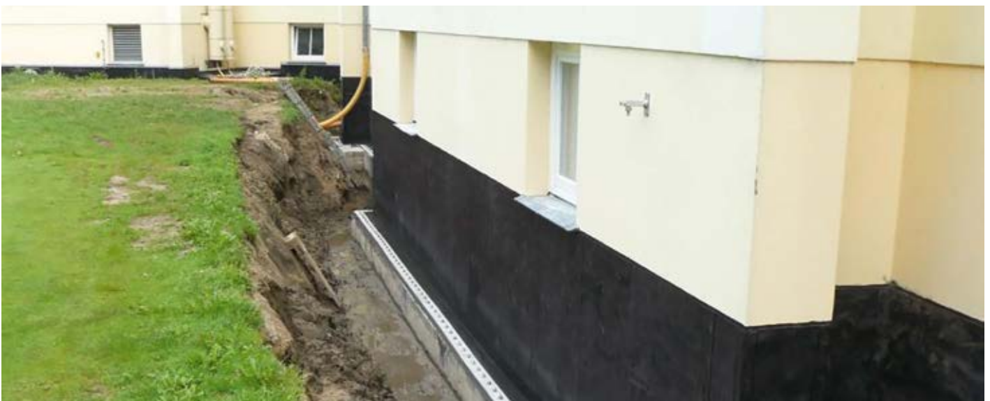
Bauwerksabdichtung in der Sanierung.
