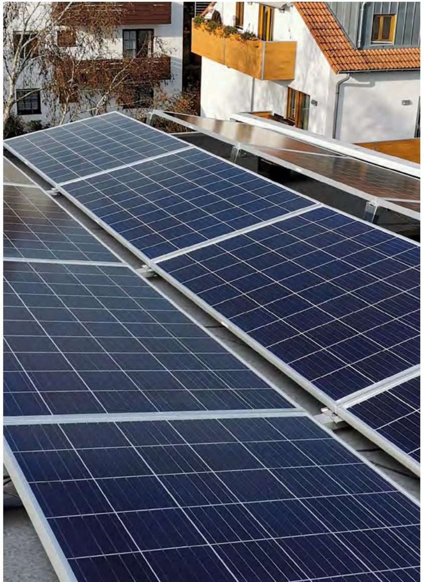
Schont die Dachhaut: PV easywave muss nicht verschraubt werden. Es ist ein aerodynamisches, durchdringungsfreies PV-System.
