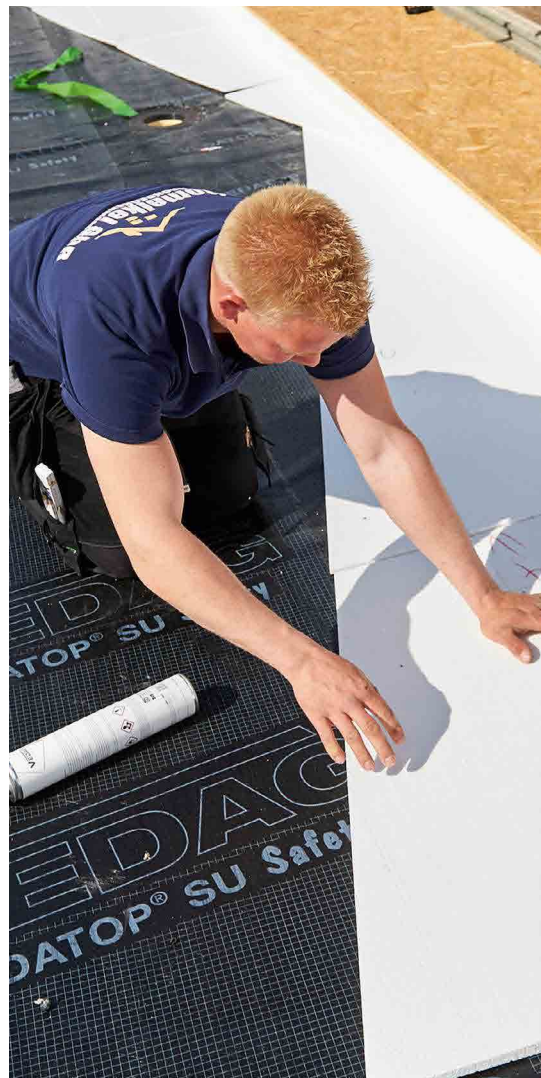
Die unterschiedlich hohen Thermazone Gefälledämmplatten lassen sich perfekt zu einer geschlossenen, geneigten Fläche zusammensetzen.
