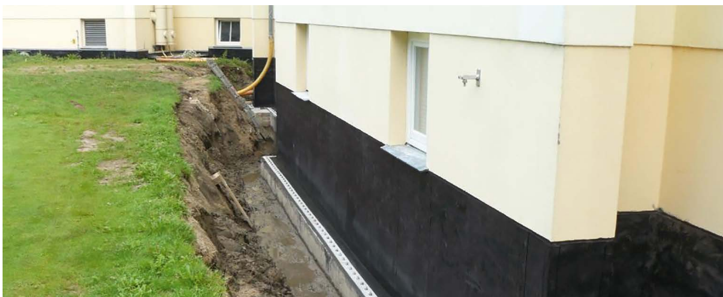
Bauwerksabdichtung in der Sanierung.
